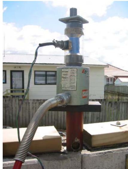
(d) Post-tensioning equipment setup
