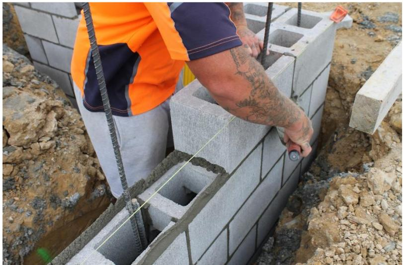
砌砖手续应符合 NZS 4210 的规定。所有砖必须按照规定的尺寸，在砂浆中逐层铺设，保持与笔直、垂直和水平一致，除非另有规定应符合 NZS 4210 的公差要求，
