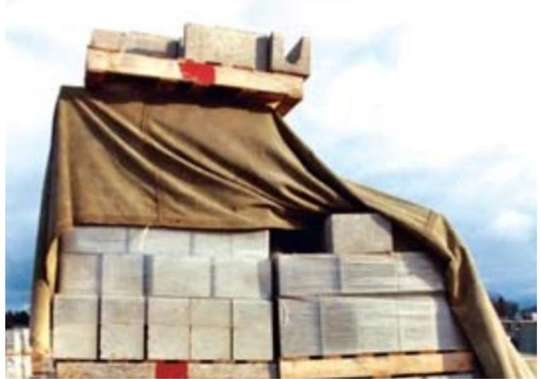
如果在砂浆完全凝固之前预计会有隔夜霜，则应在防水布下方加上一层绝缘保护。
