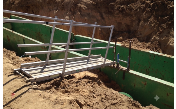
El acceso y la salida adecuados también incluyen el acceso al borde de la zanja donde se retira el sistema de protección.
